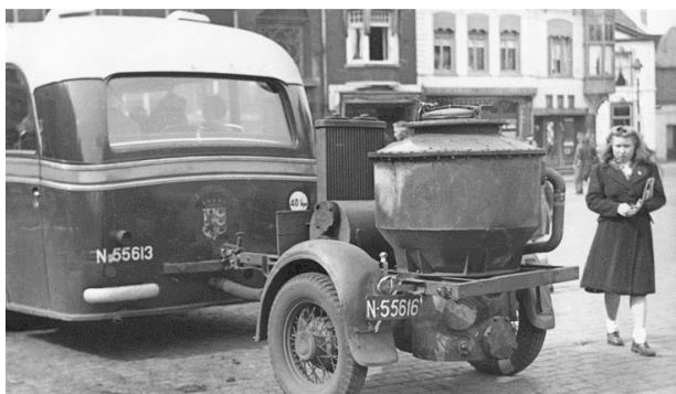
De techniek staat bekend als 'droge destillatie'. In de omvangrijke generator, die achter de auto gekoppeld was, werd hout in een van de lucht afgesloten ruimte verhit totdat er brandbare gassen vrijkwamen: vooral waterstofgas ( $H_2$ ), koolstofmonoxide (CO) en methaan ( $CH_4$ ). Maar er ontstond ook stikstofgas ( $N_2$ ). Op het  $H_2$ , het CO en het  $CH_4$  kon men de benzinemotor redelijk laten lopen.
